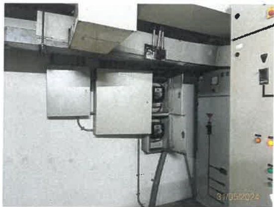
รูปที่ 9 มิเตอร์ไฟฟ้าสำหรับระบบบำบัดน้ำเสียของโครงการ โดยเฉพาะแยกจากระบบไฟฟ้าอื่นๆ
