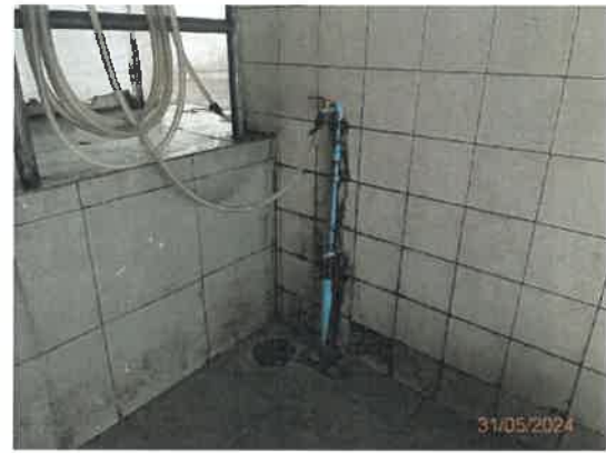
รูปที่ 21 ท่อรวบรวมน้ำจากการล้างห้องพักมูลฝอย
