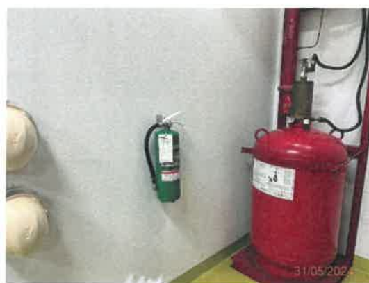
รูปที่ 32 (ต่อ) ถังดับเพลิงเคมี ชนิด ABC ขนาด 10 ปอนด์
