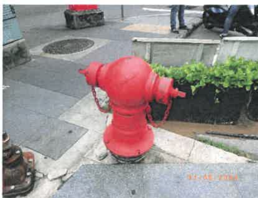
รูปที่ 33 หัวรับน้ำดับเพลิงภายนอกอาคาร
