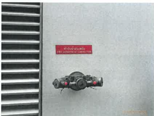
รูปที่ 33 หัวรับน้ำดับเพลิงภายนอกอาคาร
