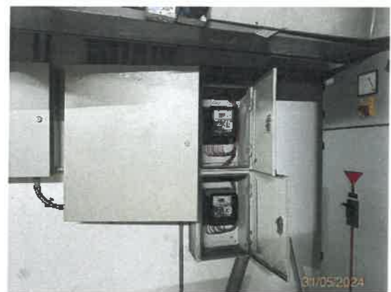
รูปที่ 9 มิเตอร์ไฟฟ้าสำหรับระบบบำบัดน้ำเสียของโครงการ โดยเฉพาะแยกจากระบบไฟฟ้าอื่นๆ
