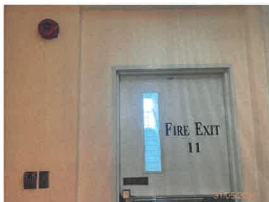
รูปที่ 39 กริ่งสัญญาณเตือนภัย (Alarm Bell)
