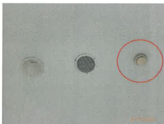
รูปที่ 38 เครื่องตรวจจับควัน (Smoke Detector)
