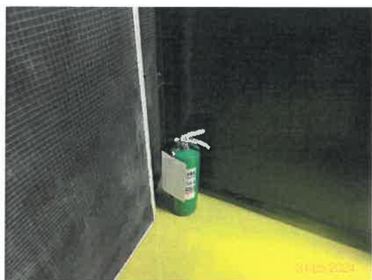
รูปที่ 32 (ต่อ) ถังดับเพลิงเคมี ชนิด ABC ขนาด 10 ปอนด์
