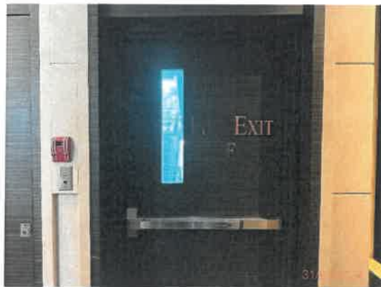
รูปที่ 40 เครื่องแจ้งเหตุโดยใช่มือดึง (Fire Alarm Manual Station)
