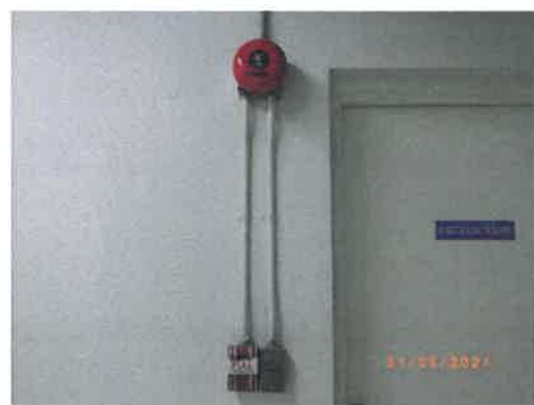
รูปที่ 39 กริ่งสัญญาณเตือนภัย (Alarm Bell)
