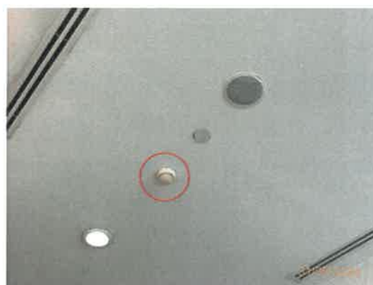
รูปที่ 38 เครื่องตรวจจับควัน (Smoke Detector)
