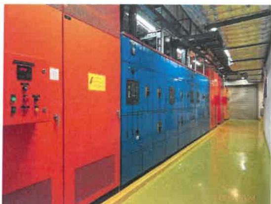
รูปที่ 24 หม้อแปลงไฟฟ้า ชนิด Dry Type
