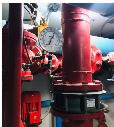
รูปภาพที่ 88 ภาพเครื่องสูบน้ำสำรอง (Electric Fire Pump)
