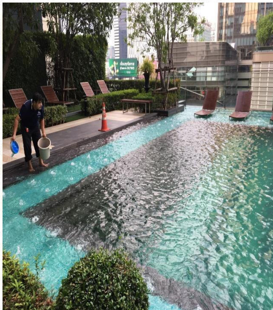
รูปภาพที่ 34 การมาเชื้อโรคสระว่ายน้ำใช้ ระบบเกลือ
