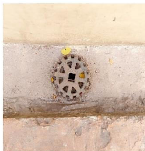
รูปภาพที่ 145 ภาพตระแกรงครอบตามท่อ ระบายน้ำ
