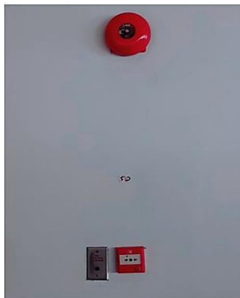
รูปภาพที่ 102 ภาพเครื่องสัญญาณเตือน อัคคีภัย
