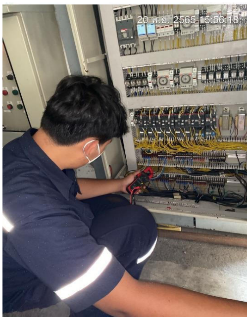
รูปภาพที่ 11 การดูแลรักษาและ ควบคุมระบบบ่อน้ำบาดาลเสีย
