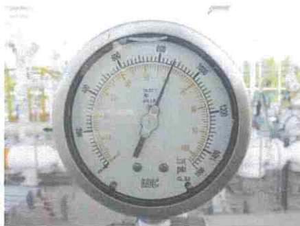
รูปความดันก่อนเข้าอุปกรณ์ปรับลดแรงดัน
