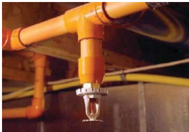
ระบบฉีดน้ำดับเพลิงอัตโนมัติ
