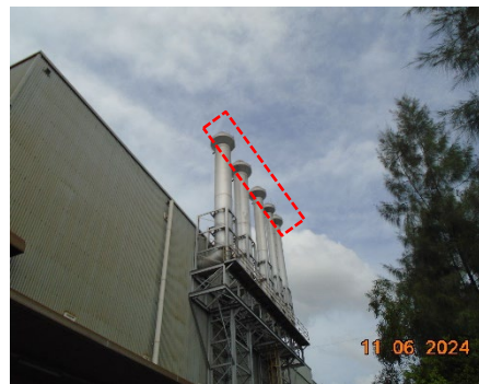
ภาพที่ 2-5 ระบบป้องกันฟ้าผ่าบริเวณปลายปล่อง
