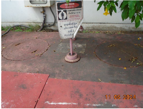
ภาพที่ 2-15 ระบบบำบัดน้ำเสียสำเร็จรูป (Septic Tank)
