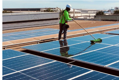
ภาพที่ 2-34 การล้างแผงเซลล์แสงอาทิตย์
