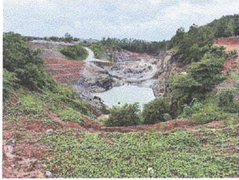
รูปที่ 1 พัฒนาหน้าเหมืองเป็นแบบขั้นบันได
