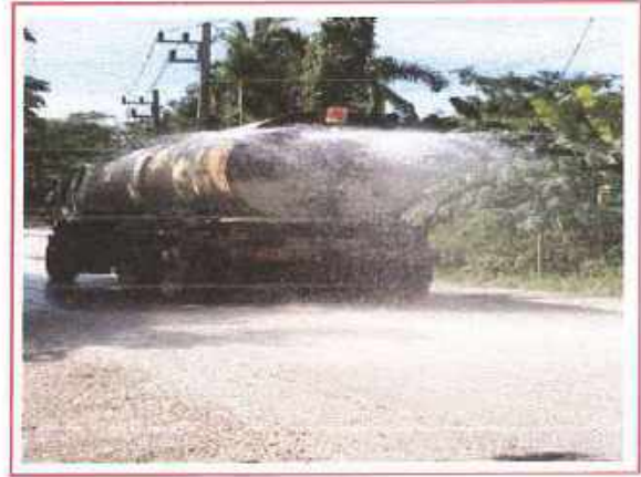
รูปที่ 2 ใช้รถบรรทุกน้ำจัดพรมบริเวณเส้นทาง ลำเลียงแร่
