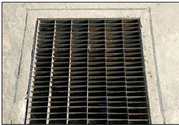
ภาพที่ 8 ตะแกรงดักขยะที่ Man hole สุดท้าย
