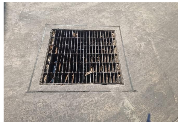
ภาพที่ 8 ตะแกรงดักขยะที่ Man hole สุดท้าย
