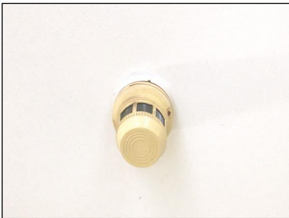
ภาพที่ 20 เครื่องตรวจจับควัน
