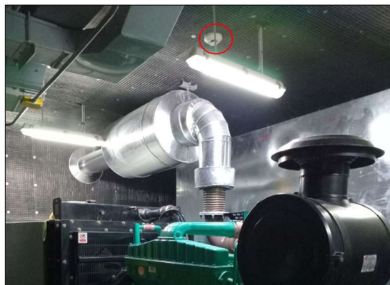
รูปที่ 2.1-30 ติดตั้งเครื่องตรวจจับควัน (Smoke Detector) ภายในห้องเครื่องไฟฟ้า
