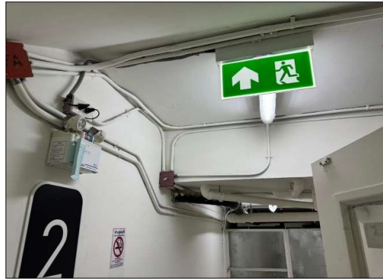
รูปที่ 2.1-38 ติดตั้งไฟฟ้าส่องสว่างให้มองเห็นช่อง ทางเดินได้และจัดให้มีป้ายทางหนีไฟที่มองเห็นชัดเจน
