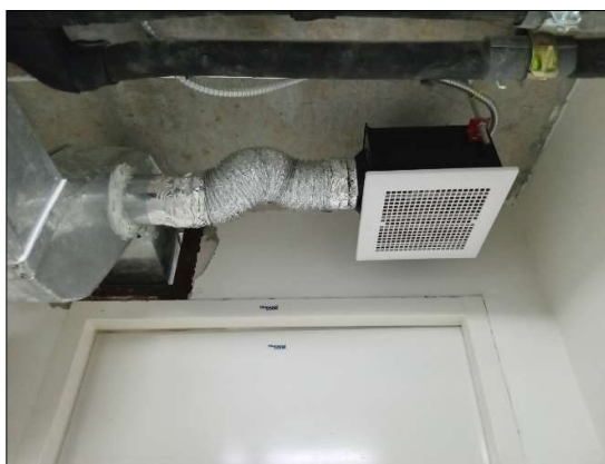
รูปที่ 2.1-21 พัดลมดูดอากาศจากห้องพักมูลฝอยของโครงการฯ
