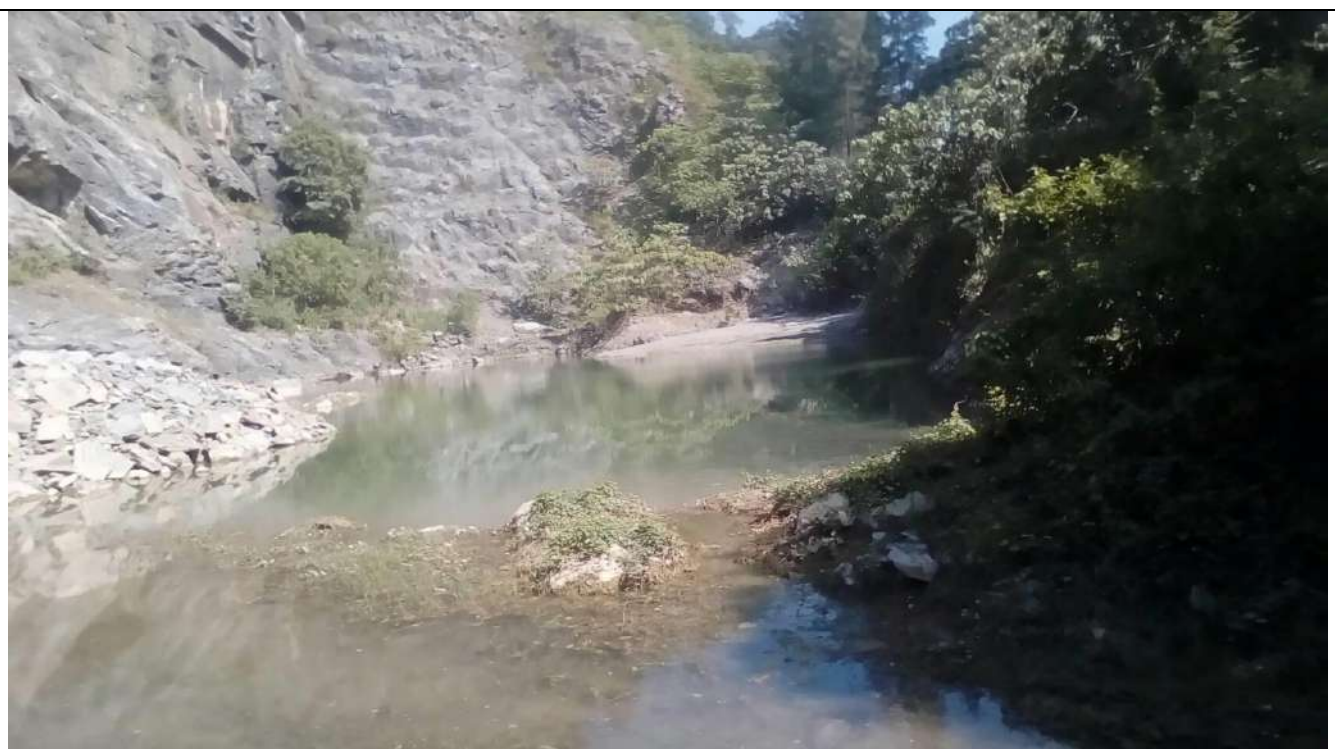
ชุมหมือ่งเก่า ถูกนำไปประโยชน์เป็นบ่อดักตะกอนที่ 1 ใช้สเปรย์โรงโม และน้ำราดถนน
