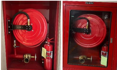
ตู้สายฉีดน้ำพร้อมอุปกรณ์
