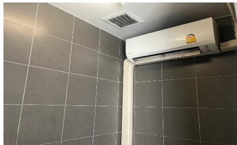
ระบบระบายอากาศภายในห้องพักมูลฝอย
