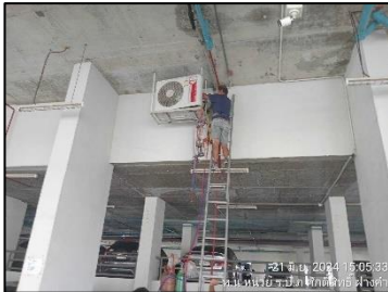
ภาพที่ 2.2-33 ล้างทำความสะอาดเครื่องปรับอากาศในพื้นที่ส่วนกลาง
