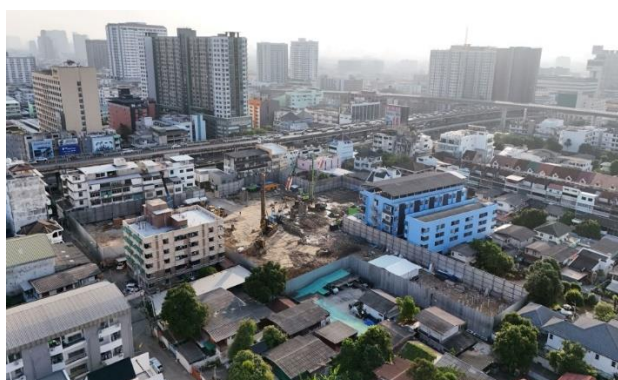
รูปที่ ก-2 รั้ว Metal Sheet สูง 6 เมตร โค้รอบบริเวณพื้นที่ก่อสร้าง
