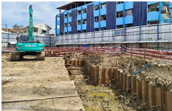
รูปที่ ก-28 การป้องกันดินพัง (Sheet Pile) ในช่วงงานฐานราก
