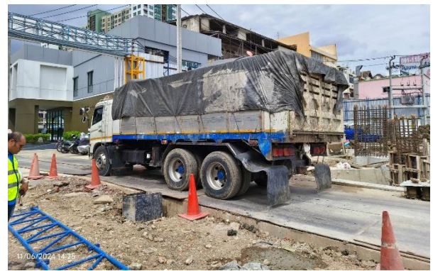
รูปที่ ก-16 รถบรรทุกที่ใช้ขนส่งวัสดุก่อสร้างมีผ้าใบคลุมอย่างมิดชิดหรือมีผนังกันส่วบรรทุกโดยรอบ
