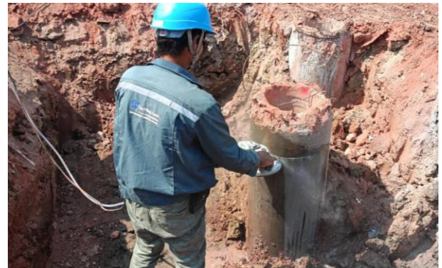
รูปที่ ก-21 สายยางสเปรย์น้ำในการตัดเสาเข็ม
