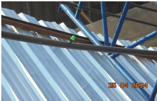
รูปที่ ก-14 สเปรย์น้ำละอองฝอย บริเวณรั้วตามแนวเขตที่ดิน โดยรอบโครงการ
