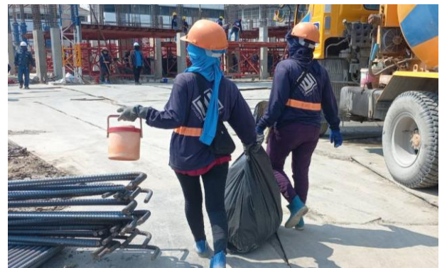
รูปที่ ก-22 การเก็บเศษวัสดุเหลือใช้ไว้ในพื้นที่ปิดคลุมมิดชิด และการปิดคลุมขณะลำเลียงเศษวัสดุ
