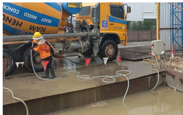
รูปที่ ก-30 ท่อระบายน้ำ และบ่อคัดตะกอนดิน
