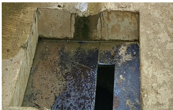
รูปที่ ก-30 ท่อระบายน้ำ และบ่อคัดตะกอนดิน
