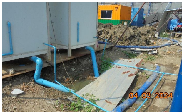
รูปที่ ก-31 ห้องน้ำ และระบบบำบัดสำเร็จรูป บริเวณพื้นที่ก่อสร้าง
