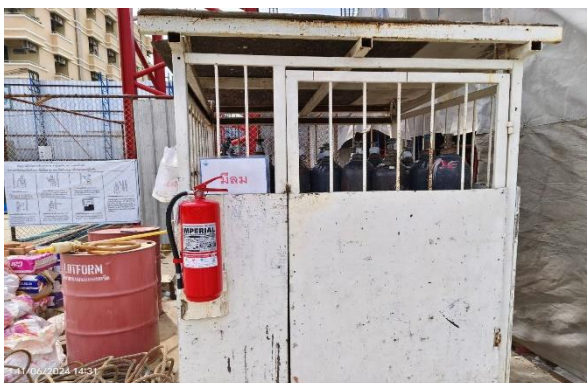
รูปที่ ก-47 พื้นที่เฉพาะสำหรับเก็บเชื้อเพลิง และวัสดุไวไฟ และป้ายห้ามสูบบุหรี่ และนำวัตถุไวไฟเข้าไปในพื้นที่ก่อสร้าง
