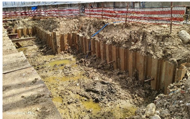
รูปที่ ก-28 การป้องกันดินพัง (Sheet Pile) ในช่วงงานฐานราก
