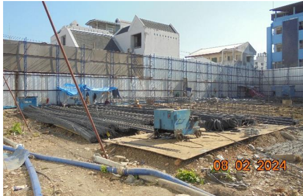
รูปที่ ก-48 พื้นที่สำหรับการเชื่อมตัดโลหะ และที่จัดเก็บวัสดุติดไฟอยู่ในพื้นที่และมีระยะที่เหมาะสม
