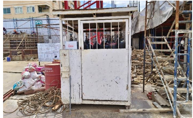
รูปที่ ก-48 พื้นที่สำหรับการเชื่อมตัดโลหะ และที่จัดเก็บวัสดุติดไฟอยู่ในพื้นที่และมีระยะที่เหมาะสม
