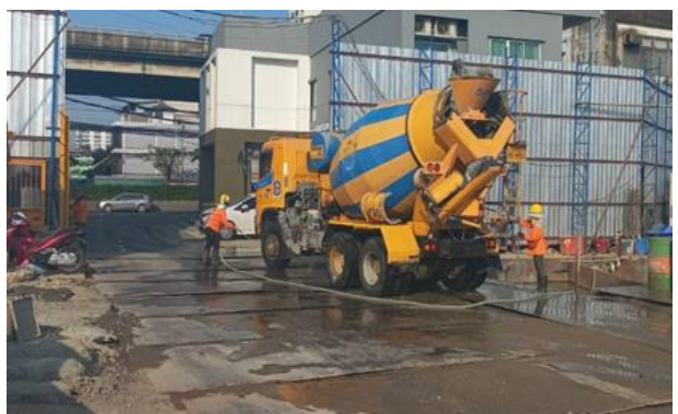
รูปที่ ก-11 การล้างล้อรถ และตัวถังรถที่เข้า-ออก บริเวณพื้นที่โครงการ
