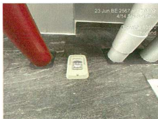
ภาพที่ 36 ลำโพงแจ้งเหตุเพลิงไหม้ (Voice Tone Alarm Loudspeaker)
