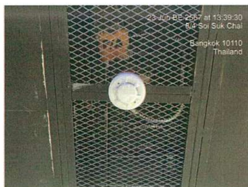
ภาพที่ 33 เครื่องตรวจจับควัน (Smoke Detector)
