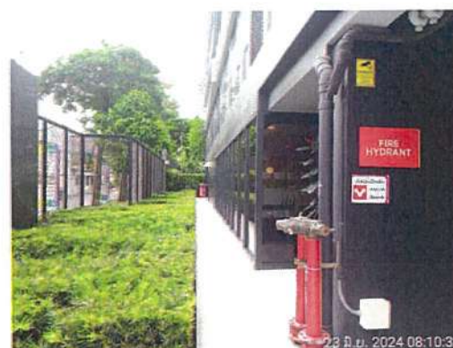
ภาพที่ 30 หัวรับน้ำดับเพลิงภายนอกอาคาร (Fire Department Connector FDC)
