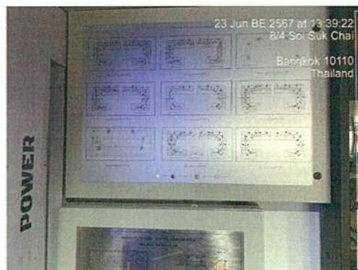
ภาพที่ 32 แผงควบคุม (Fire Alarm Control Panel FCP)
