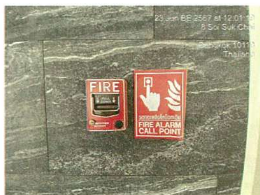
ภาพที่ 35 เครื่องแจ้งเหตุโดยใช่มือคัง (Manual Station)
