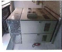
1) ติดตั้งห้องแม่ไฟฟ้าชนิด Dry Type ขนาด 1,000 kVA จำนวน 1 ชุด ซึ่งดำเนินการผู้ควบคุมดองการให้ไฟฟ้าประมาณ 600 kVA
