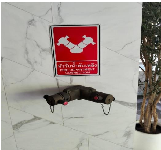
รูปที่ 2.4.8-3 หัวรับน้ำดับเพลิงภายนอกอาคาร
