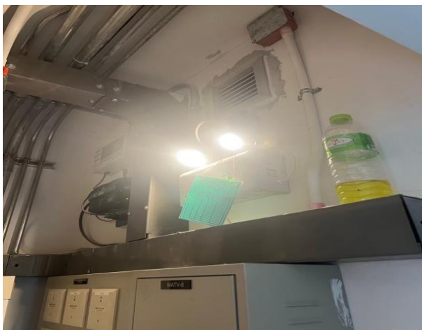
รูปที่ 2.4.8-9 ไฟส่องสว่างฉุกเฉิน
