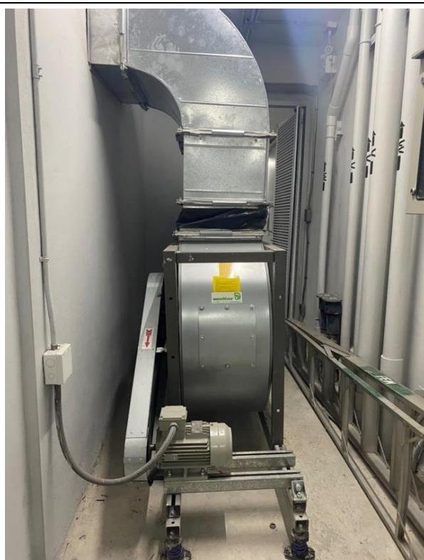
ภาคผนวกที่ 3-38 ระบบป้องกันอัคคีภัย และระบบระบายอากาศ ภายในระบบจอตรยหนต์อัตโนมัติ
