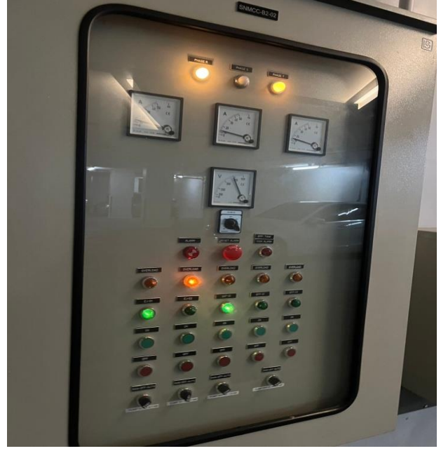
รูปที่ 2.4.3-2 ตู้ควบคุมระบบบำบัดน้ำเสีย
