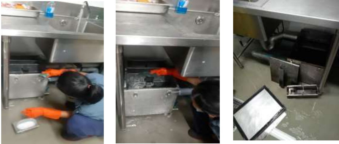
ภาพที่ 5 -9 ถึง ตักไขมันในห้องครัว ตักไขมันทุกสัปดาห์
