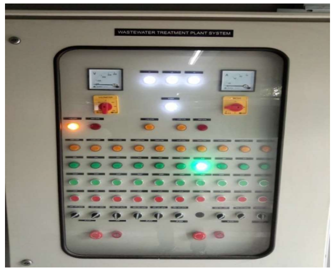
รูปที่ 2.5.1-3 ตู้ควบคุมระบบบำบัดน้ำเสีย
