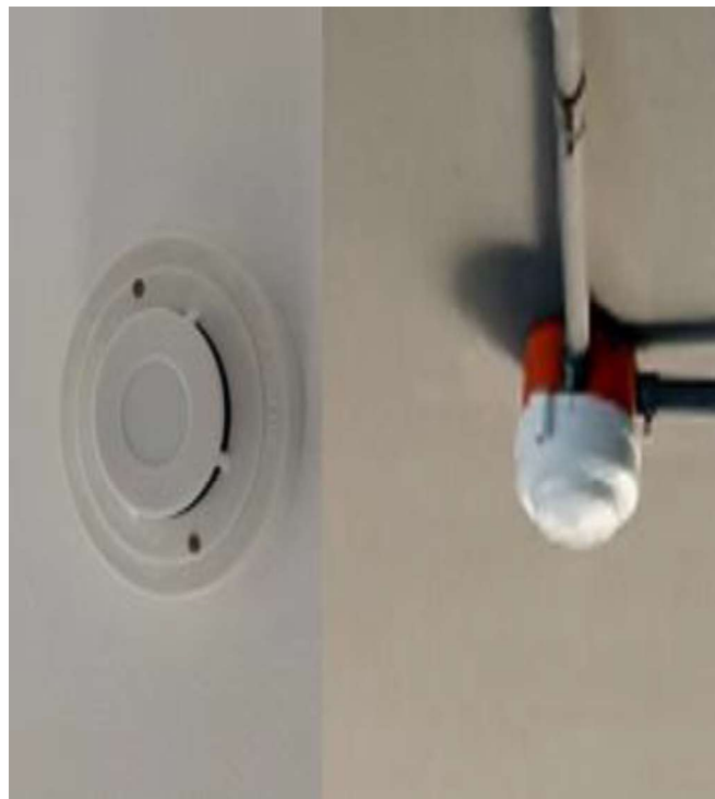
รูปที่ 2.7.2-2 อุปกรณ์ตรวจจับควันและความร้อน
