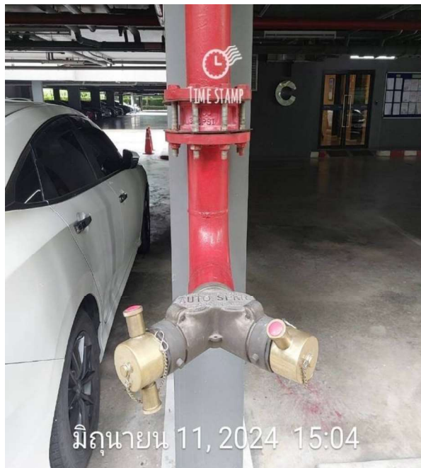
รูปที่ 2.7-2 หัวรับน้ำดับเพลิงภายในอาคาร
