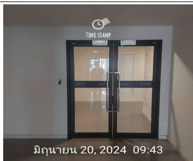
รูปที่ 2.1-2 ติดตั้งประตูคีย์การ์ด (Key Card) ชั้นที่ 2 อาคาร C
