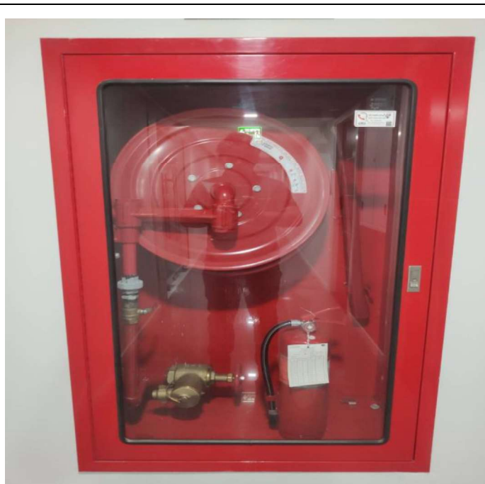
รูปที่ 2.6-3 เก็บบายน้ำดับเพลิงพร้อมอุปกรณ์
