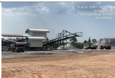
รูป Q สร้างอาคารปิดคลุม Hopper, Primary Crusher และตระแกรงคัดขนาดแร่ พร้อมทั้งติดตั้งระบบสเปรย์น้ำ
