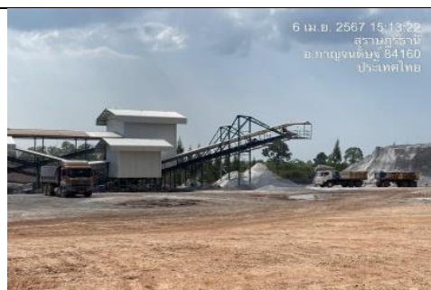
รูป W สร้างอาคารปิดคลุม Hopper, Primary Crusher และ ตระแกรงคัดขนาดแร่ พร้อมทั้งติดตั้งระบบสปาร์กน้ำ
