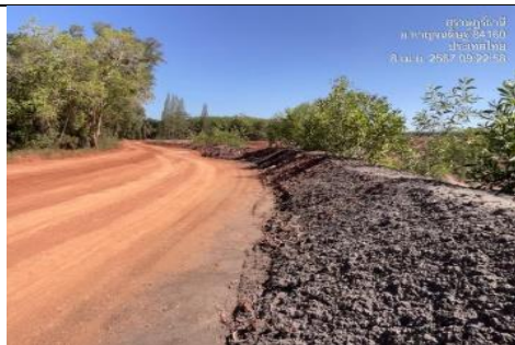
รูป Q สร้างคันทำนบความกว้างฐาน 5 เมตร สูง 3 เมตร และสันคันด้านบนกว้าง 2.5 เมตรพร้อมปลูกพืชคลุมดิน
