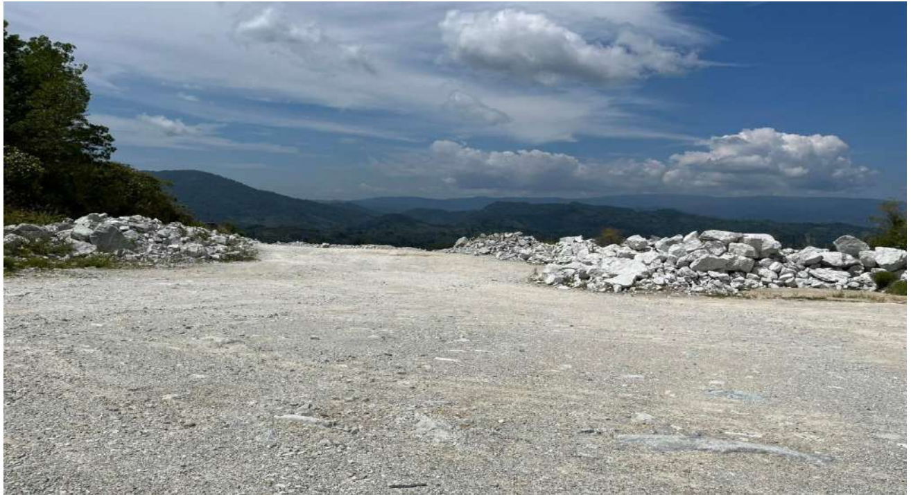
รูปที่ ๖ พื้นลานกองแร่เปลือกดินและเศษหินบดอัดแน่น
