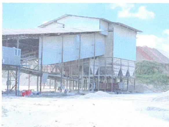
รูปที่ 15 การปิดคลุมอาคารโรงโม่หิน ชุด Product Screen
