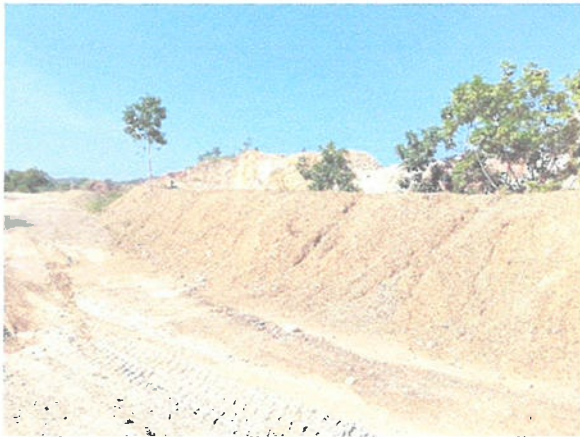
รูปที่ 7 คันทำนบดินด้านทิศตะวันออกเฉียงใต้ตาม แนวหมุด 7-8-9-1 เตรียมปลูกต้นไม้เพิ่มเติม
