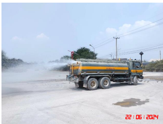
รูปที่ 10 การฉีดพรมน้ำเพื่อลดการฟุ้งกระจายของฝุ่นละออง
