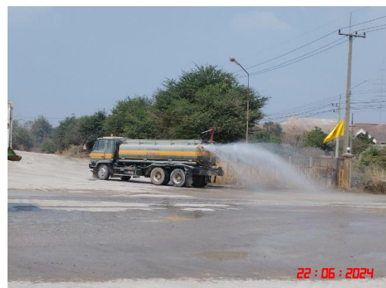
รูปที่ 10 การฉีดพรมน้ำเพื่อลดการฟุ้งกระจายของฝุ่นละออง
