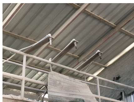
รูปที่ 2-12: การสเปรย์น้ำภายในโรงโม่
