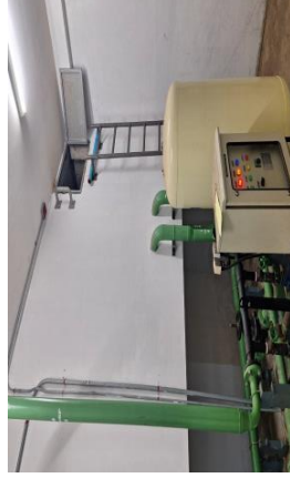
รูปที่ 2.4.1 ถังเก็บน้ำขึ้นดาดฟ้า
