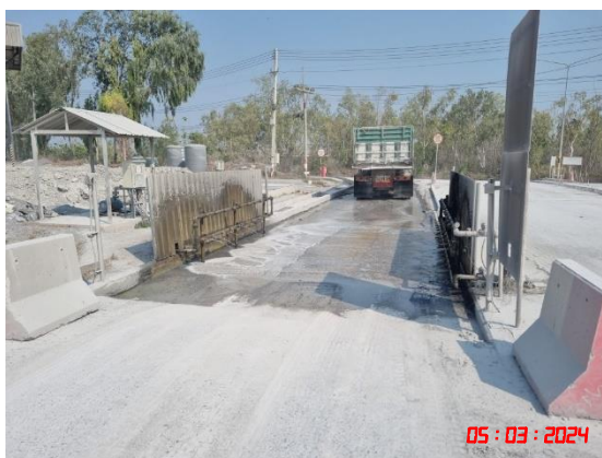
รูปที่ 8 ลานล้างล้อรถบรรทุก
