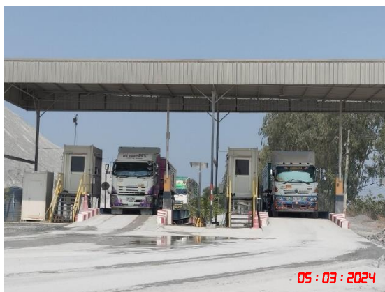
รูปที่ 14 จุดชั่งน้ำหนักรถบรรทุก
