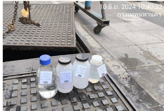
รูปที่ 4.4-1 การเก็บตัวอย่างคุณภาพน้ำทิ้ง
