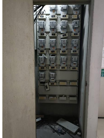
ห้องไฟฟ้า และภายในห้องไฟฟ้า ประกอบด้วยมิเตอร์ไฟของแต่ละห้องพักอาศัย
