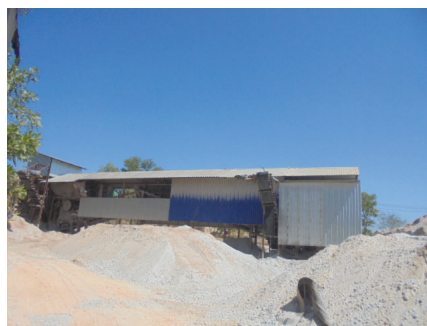
รูปที่ 2-11: การปิดคลุมอาคารโรงแต่งแร่
