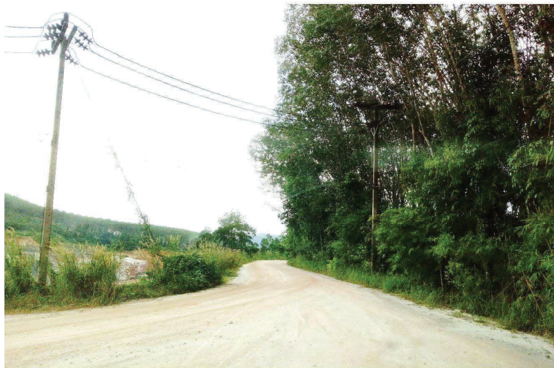
ถนนลูกรังบดอัดแน่นจากประตานบัตรเชื่อมกับถนนสายหลัก
