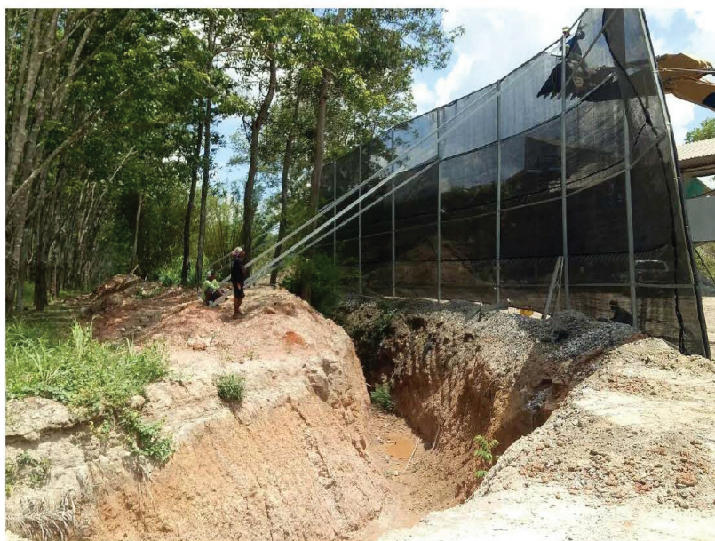
ดูระบายน้ำรอบๆพื้นที่โรงแต่งแร่และแนวป้องกันฝุ่นละอองจากโรงแต่งแร่
