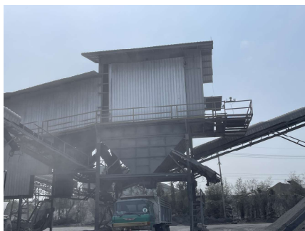
รูปที่ 2-29: การปิดคลุมอาคารโรงโม่หิน
