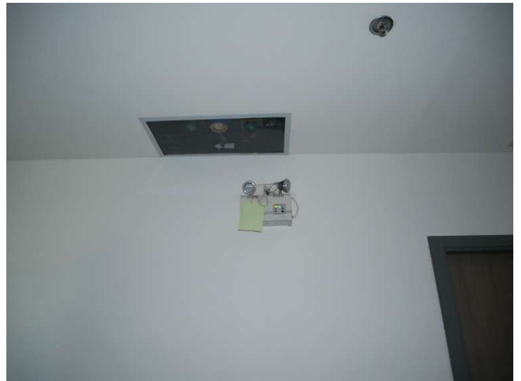
ภาพตัวอย่างไฟส่องสว่างฉุกเฉิน
