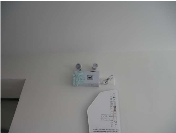
ภาพตัวอย่างไฟส่องสว่างฉุกเฉิน
