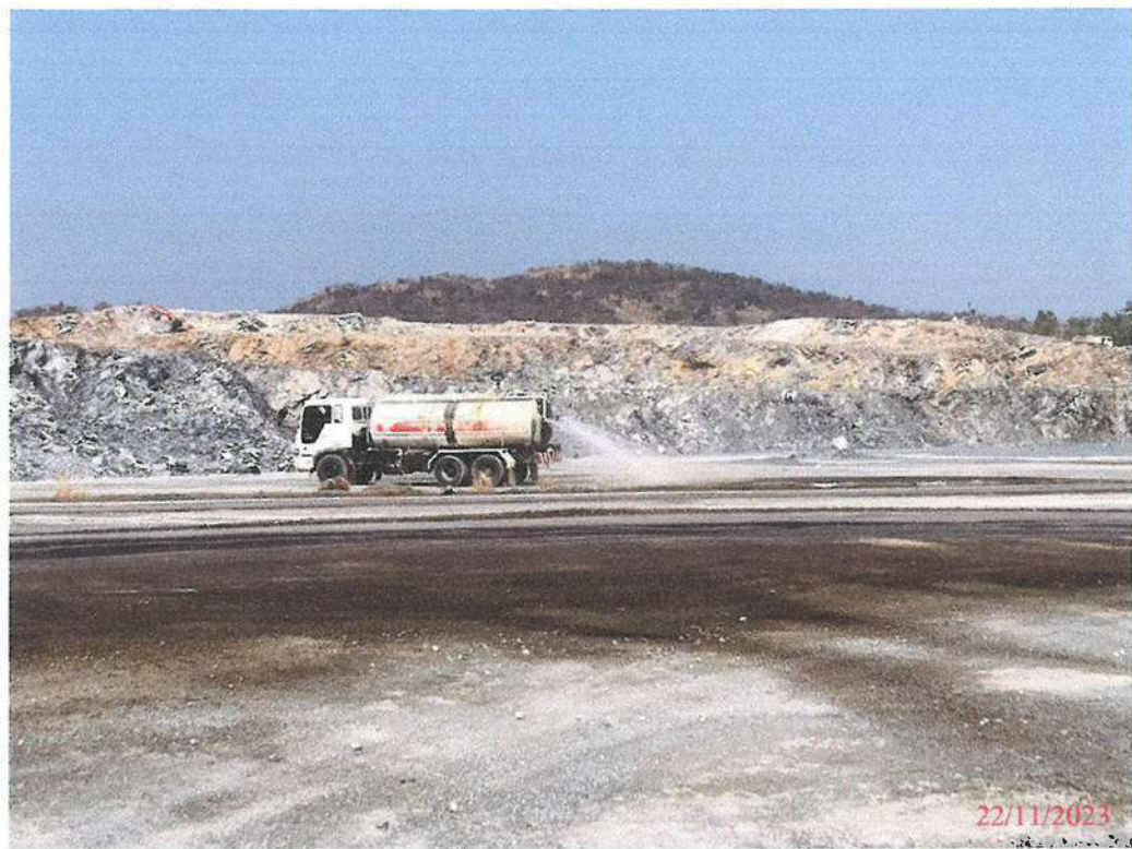
ภาพที่ 7 : การนำน้ำจากบ่อกักน้ำคัดตะกอนมาใช้ลาดถนนและพื้นที่ต่างๆที่เกิดฝุ่นฟุ้งกระจาย
