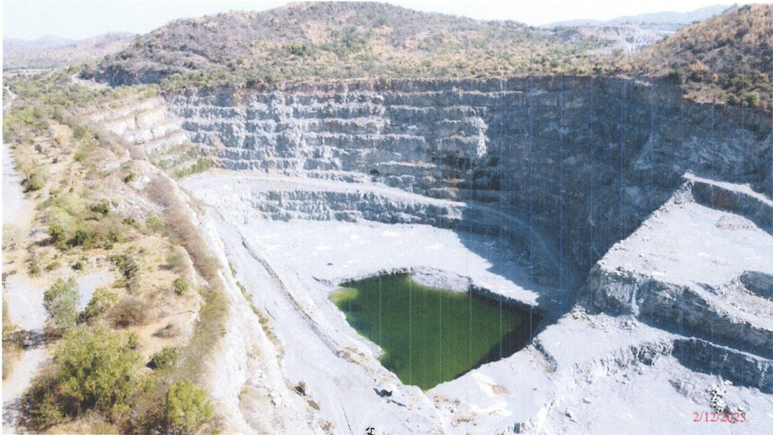
ภาพ ที่ 10 : บ่อพักน้ำดักตะกอนบริเวณที่พื้นที่ต่ำสุดของหน้าเหมืองภายในพื้นที่โครงการ
