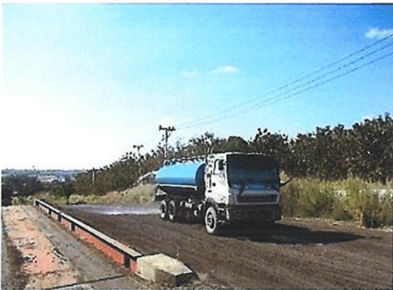
รดน้ำเพื่อป้องกันฝุ่นในทางขนส่งแร่
