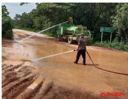
รูปที่ 11 การฉีดพรมน้ำในพื้นที่โครงการ
