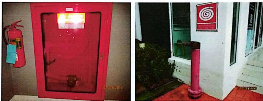
รูปที่ 5 แสดงอุปกรณ์ดับเพลิงแบบมือถือ และตู้ดับเพลิง และหัวรับน้ำดับเพลิง
