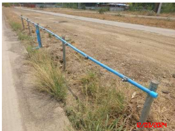
รูปที่ 16 ระบบสเปรย์น้ำบริเวณจุดล้างล้อรถบรรทุก
