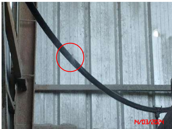
ระบบสเปรย์น้ำบริเวณแหล่งกำเนิดฝุ่นละออง
