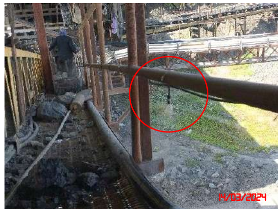
ระบบสเปรย์น้ำบริเวณแหล่งกำเนิดฝุ่นละออง
