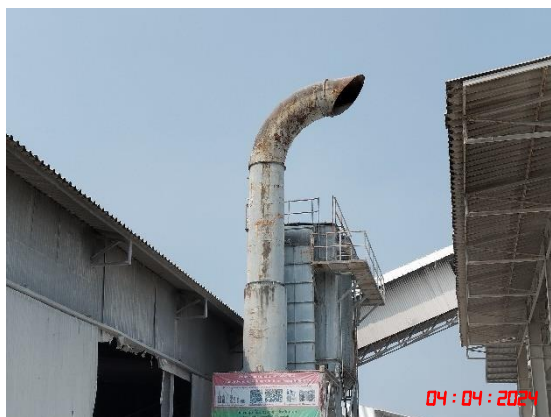
รูปที่ 12 ระบบกรองฝุ่นภายในโรงแต่งแร่
