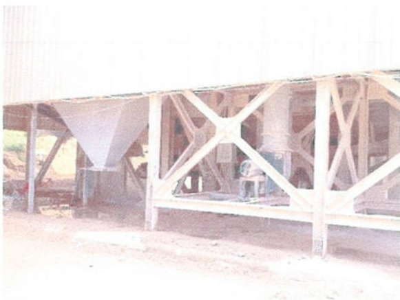
รูปที่ 20 เตรียมการติดตั้งระบบดูดฝุ่นละอองขณะโม่หินแบบ Bag Filter
