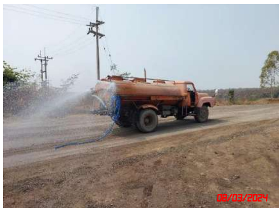
รูปที่ 8 การฉีดพรมน้ำเพื่อลดการฟุ้งกระจายของฝุ่นละออง
