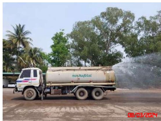
รูปที่ 8 การฉีดพรมน้ำเพื่อลดการฟุ้งกระจายของฝุ่นละออง
