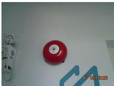
สัญญาณแบบกริ่ง (Alarm Bell)
