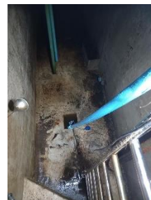
ภาพที่ 2-17 การทำความสะอาดและตรวจสอบถังเก็บน้ำสำรอง
