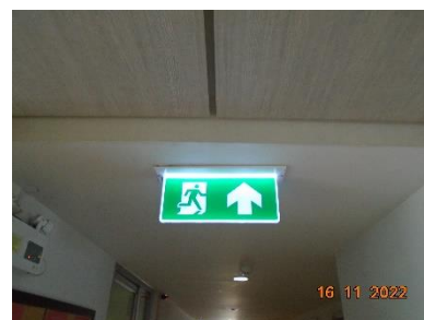
ป้ายบอกทางหนีไฟ (Fire Exit Sign Luminaire)
