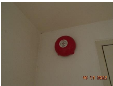
สัญญาณแบบกริ่ง (Alarm Bell)
