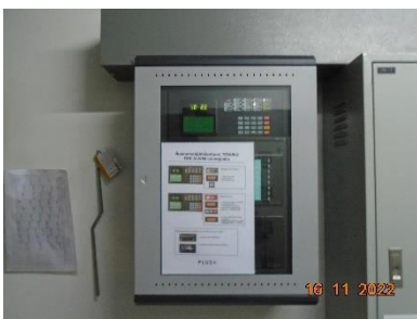
แผงควบคุมระบบสัญญาณแจ้งเหตุเพลิงไหม้ (Fire Alarm Control Center ; FCC)
