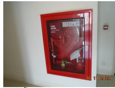
ตู้สายฉีดน้ำดับเพลิง (Fire Hose Cabinet)
