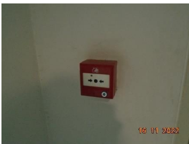
ระบบแจ้งเหตุแบบใช้มือกด (Manual Station)
