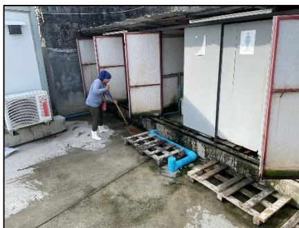
รูปที่ 3-16 ห้องส้วมสำหรับคนงานภายในพื้นที่ก่อสร้าง และมีการติดตั้งระบบบำบัดน้ำเสียสำเร็จรูปเพื่อบำบัดน้ำเสีย
