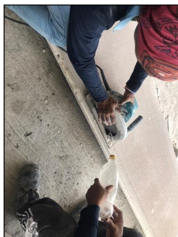
รูปที่ 3-12 ฉีดน้ำตลอดเวลาระหว่างการขุด/เจาะ/ตัด/ขัดผิว เพื่อลดการเกิดฝุ่นละออง
