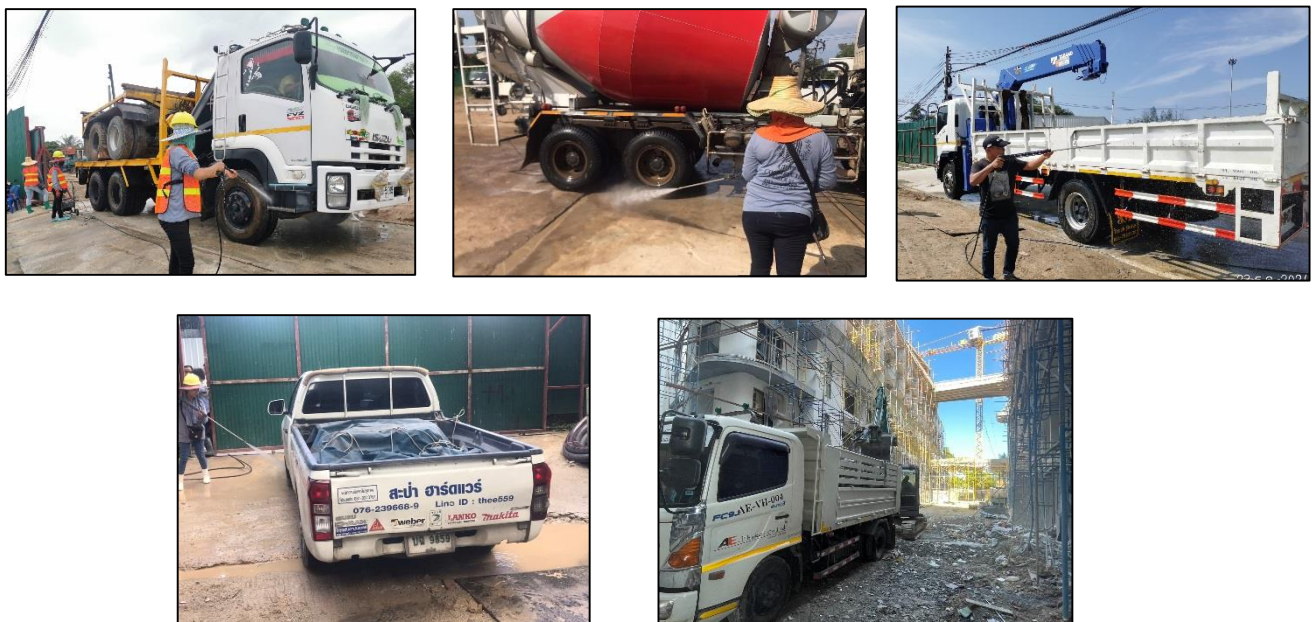
รูปที่ 3-4 การล้างล้อรถก่อนออกจากพื้นที่โครงการ
