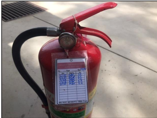
รูปที่ 3-24 ถังดับเพลิงเคมีแห้ง ขนาด 4 กิโลกรัม ภายในพื้นที่ก่อสร้าง
