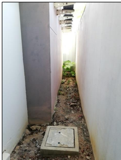
รูปที่ 3-3 บ่อหน่วงน้ำฝนและท่อระบายน้ำฝน
