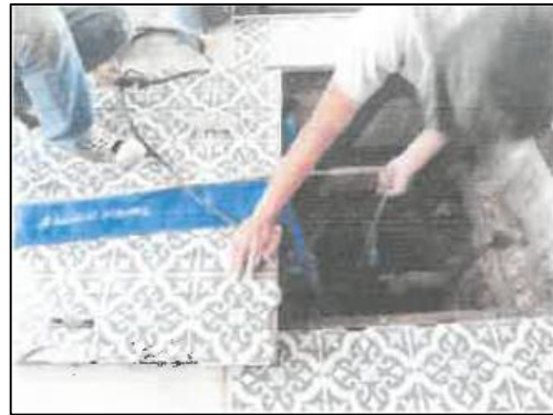
รูปที่ 3-5 ดุดตะกอนในถังน้ำดี
