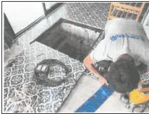
รูปที่ 3-5 ดุดตะกอนในถังน้ำดี
