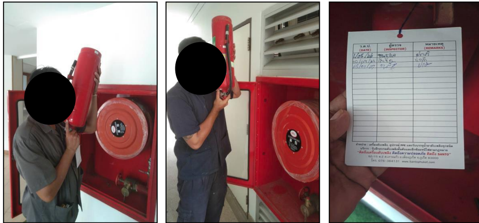
รูปที่ 3-30 เจ้าหน้าที่ดูแลตรวจเช็คระบบป้องกันอัคคีภัยและระบบเตือนภัยภายในโครงการ
