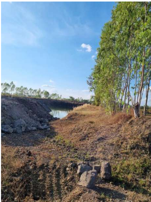
รูปที่ 5.2 พื้นที่ทำเหมืองแล้ว ทยอยย้ายเปลือกดินมาถมกลับ
