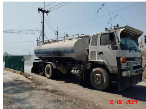
รูปที่ 8 การฉีดพรมน้ำเส้นทางขนส่งแร่
