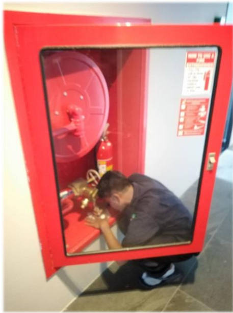
ภาพที่ 2-24 ตรวจเช็คถังดับเพลิง
