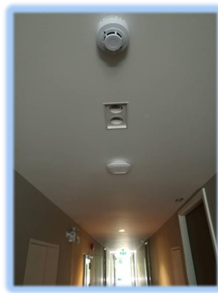
ภาพที่ 2-13 Smoke Detector & Sprinkler
