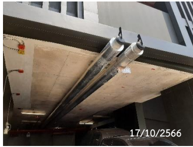
พัดลมระบายอากาศห้อง Generator
