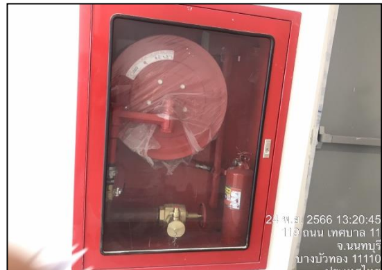
ภาพที่ 20 ตรวจเช็คอุปกรณ์ดับเพลิง
